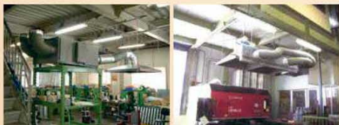
HG321Dによる粉塵局所吸引例
